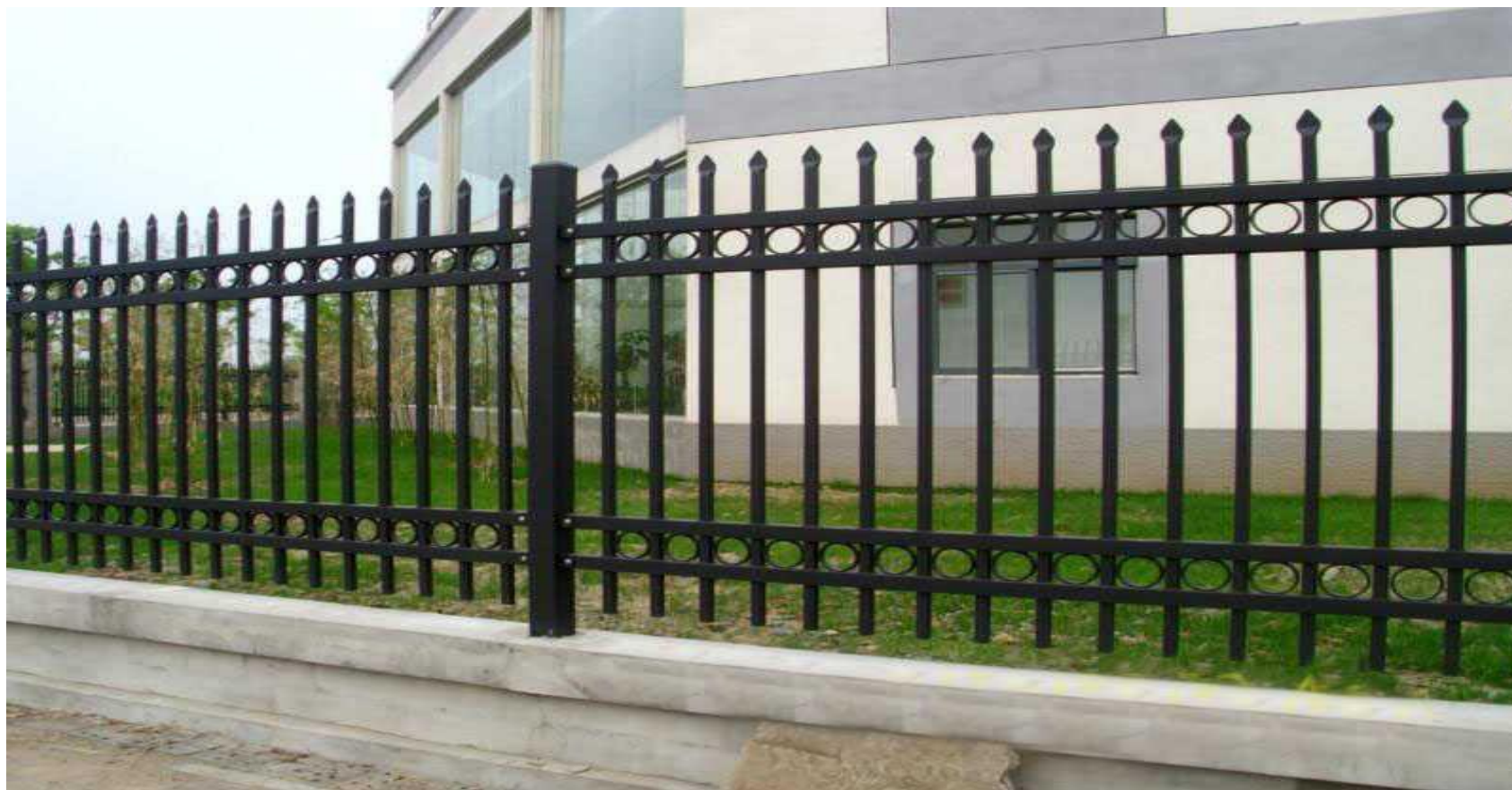
围栏高度为 1.5 米，围栏立柱之间的宽度为 4 米
