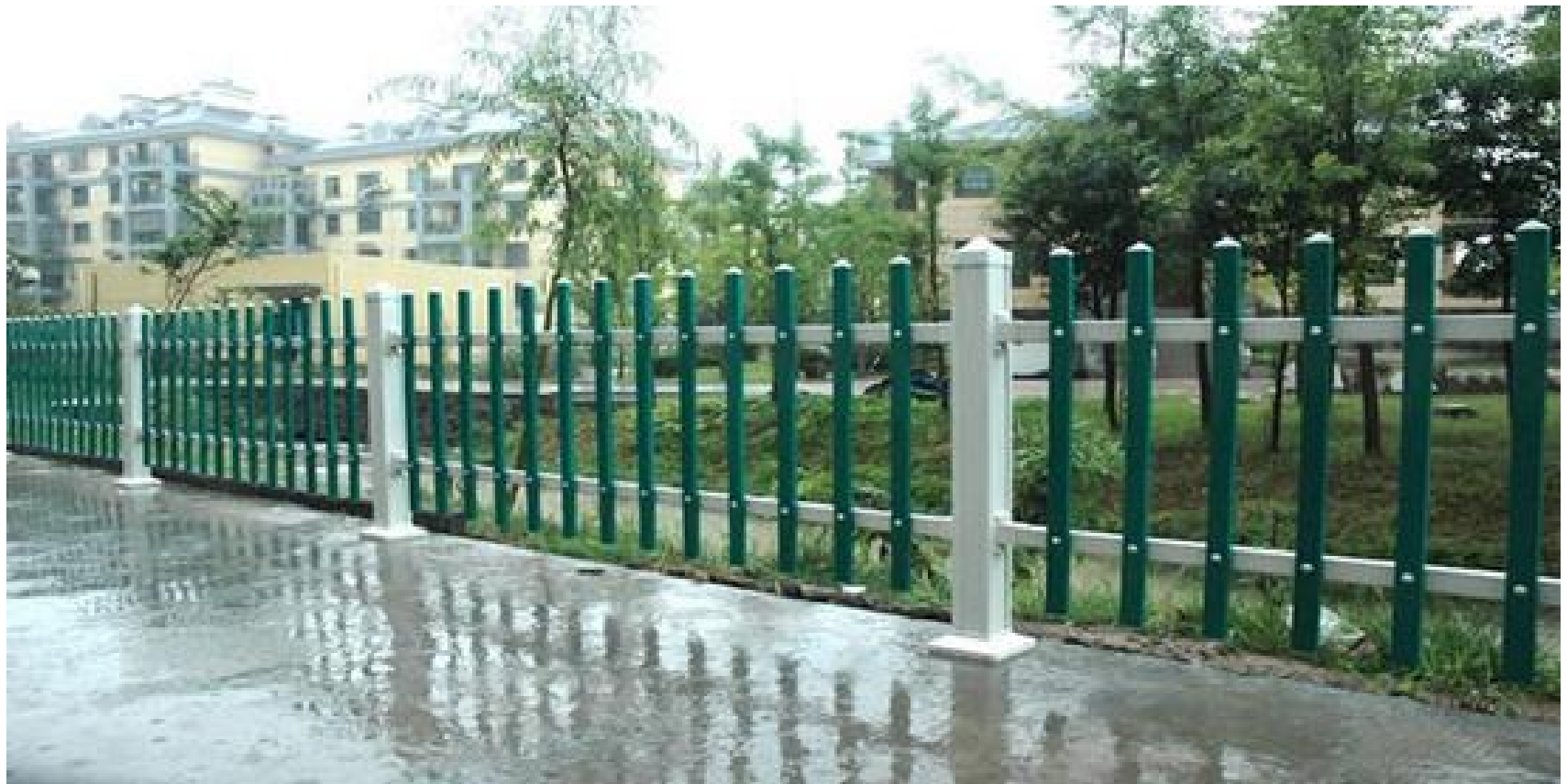
围栏高度为 1.5 米，围栏立柱之间的宽度为 4 米
