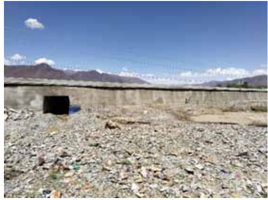
厂区暂定取水点
